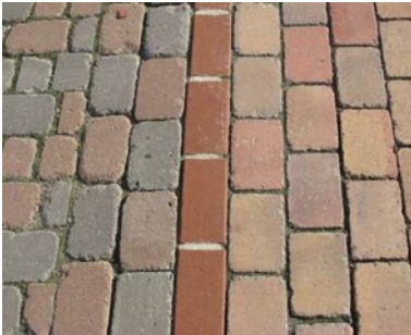
Betonrechteckpflaster abgegrenzt mit rotem Klinker
