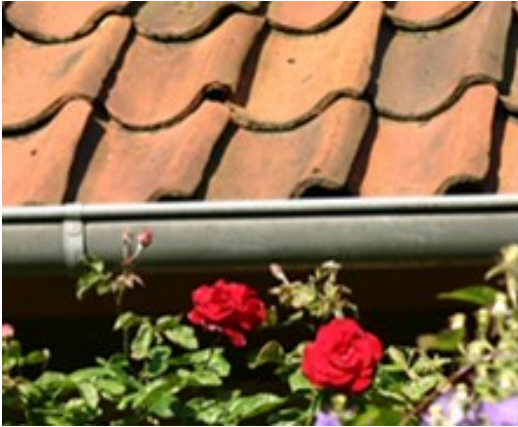
Abb. 8 Hist. Hohlpfanne als Sinnbild einer langlebigen Dacheindeckung
