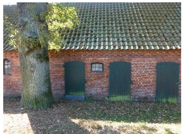
Abb. 26 Holztüren (außen angeschlagen) mit Rundbögen
