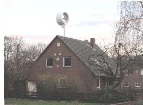
Abb. 32 Aufdach-Kleinwindanlage
