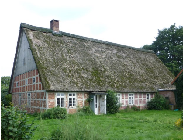
Ostereistedt – Fachwerk-Vierständerhaus von 1855 mit Reetdach
