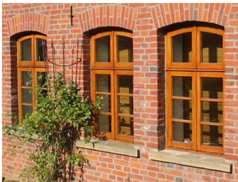
Abb. 20 Fenster im Mauerwerk
