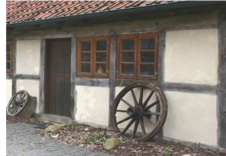
Abb. 17 Lehmputz im Fachwerk
