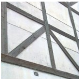
Abb. 14 Aufgeklebtes Pseudofachwerk (negativ)
