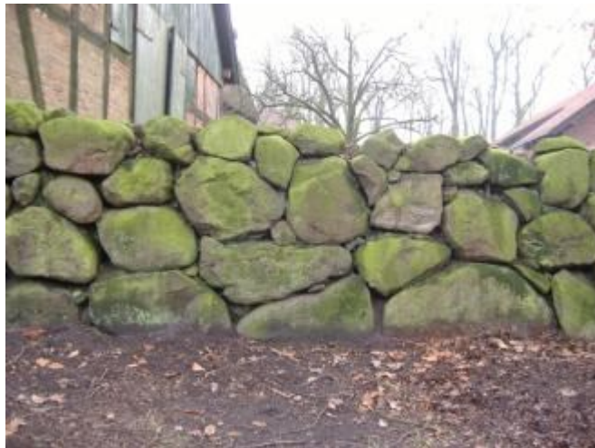
Findlingsmauer in Winderswohde
