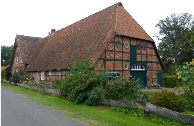
Abb. 4 Krüppelwalm- und Satteldach
