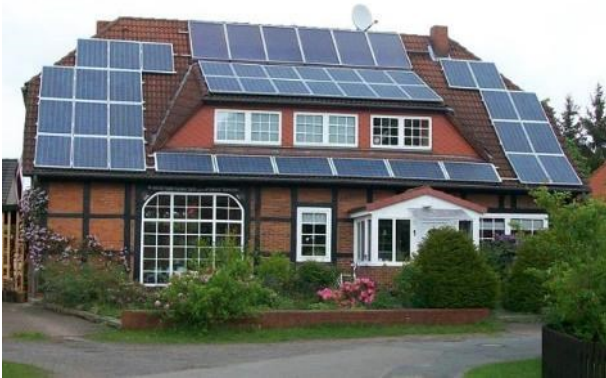
Abb. 29 Negativbeispiel: Weder farblich noch gestalterisch abgestimmte Aufdach-Anlage
