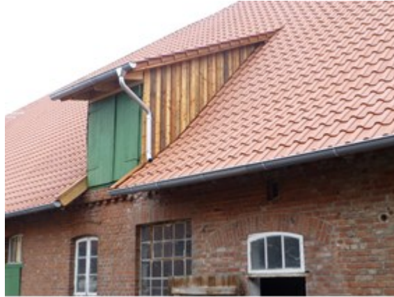
Abb. 9 Neue Dacheindeckung mit naturrotem Tondachstein'
