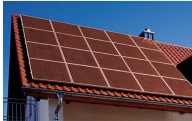
Abb. 30 Farblich angepasste Aufdach-Anlage mit ruhigem Gesamterscheinungsbild ( www.abakus-solar.de )
