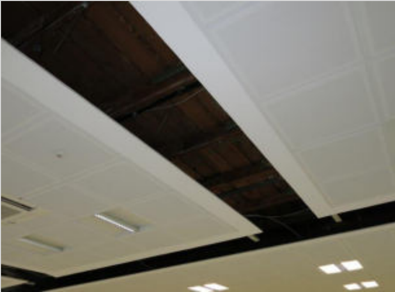
Blick durch die Decke.
