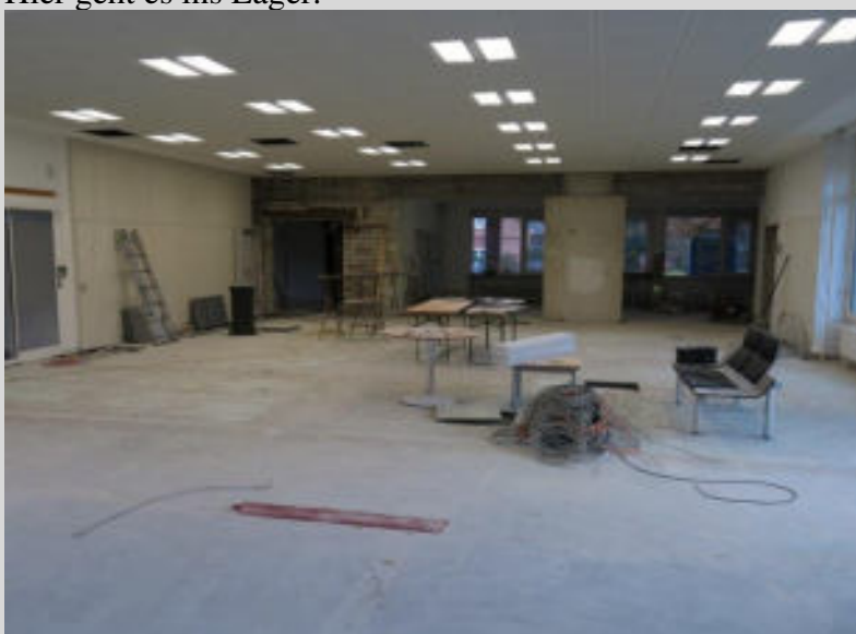
Blick auf Lagerraum und Kühllecke. Links entstehen Kassen- und Postbereich.
