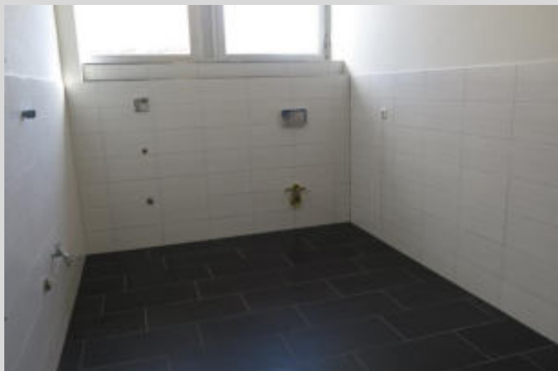
Die Toiletten - fast fertig.
