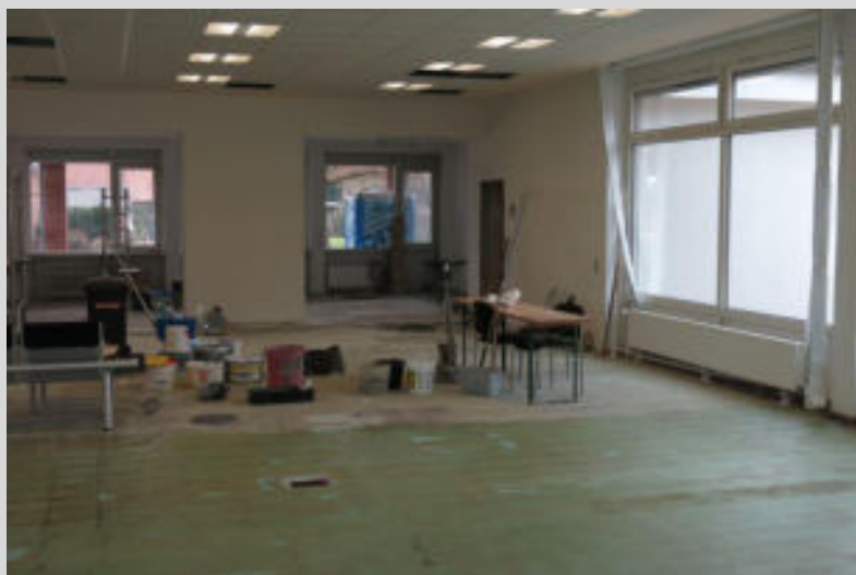
Der Fußboden wird vorbereitet.
